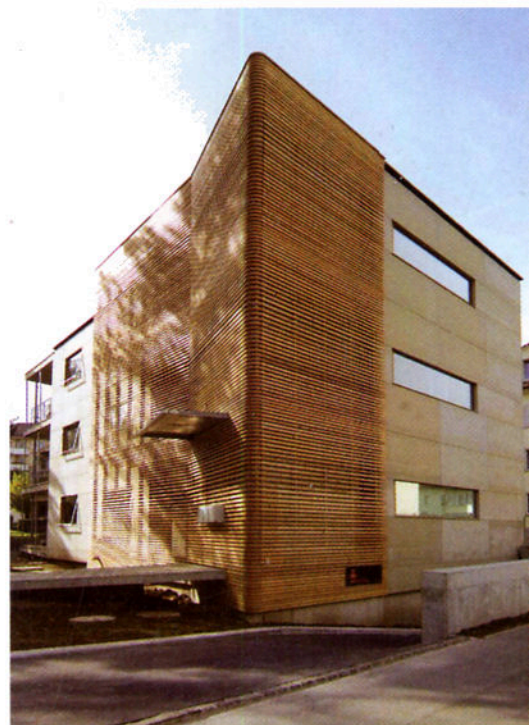
La cage d'escalier est en mélèze non poncé. Elle surplombe la voie d'accès au parking sous-terrain.
